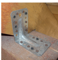
Montaż złącza kąтового za pomocą wkrętów do płyty GK i gwoździ papowych
