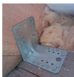
Montaż złącza kąтового za pomocą gwoździ papowych
